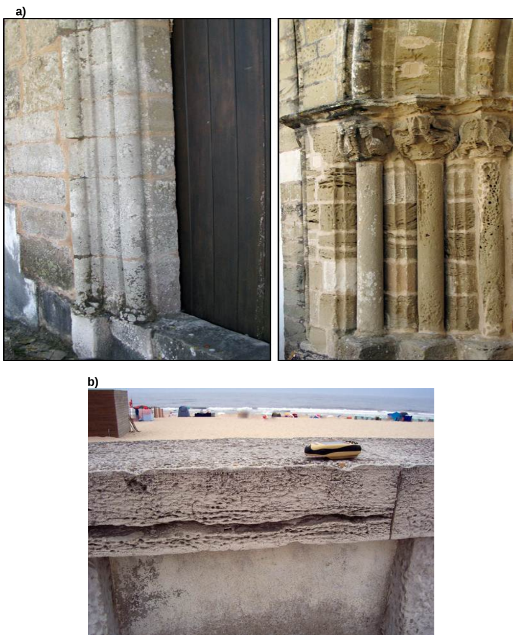
Fig. 6: Comparação de aspetos de erosão em diferentes fachadas do mesmo monumento (a) e em diferentes superfícies do mesmo bloco (b).
